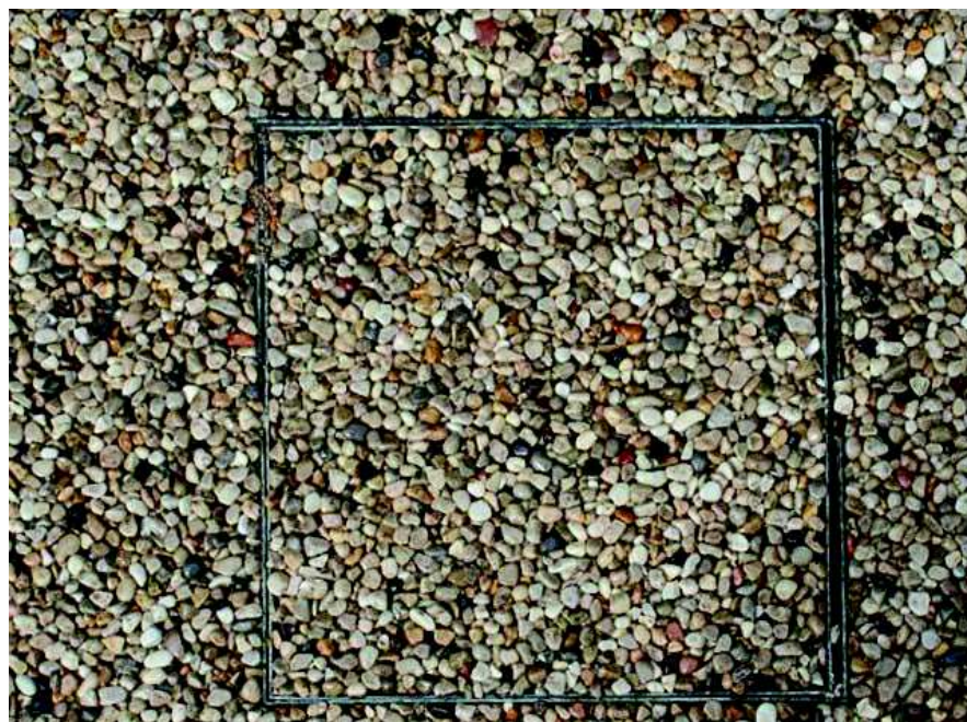
Sopra, esempio indicativo di controtelaio e coprichiusino con finitura simile a quella di progetto
