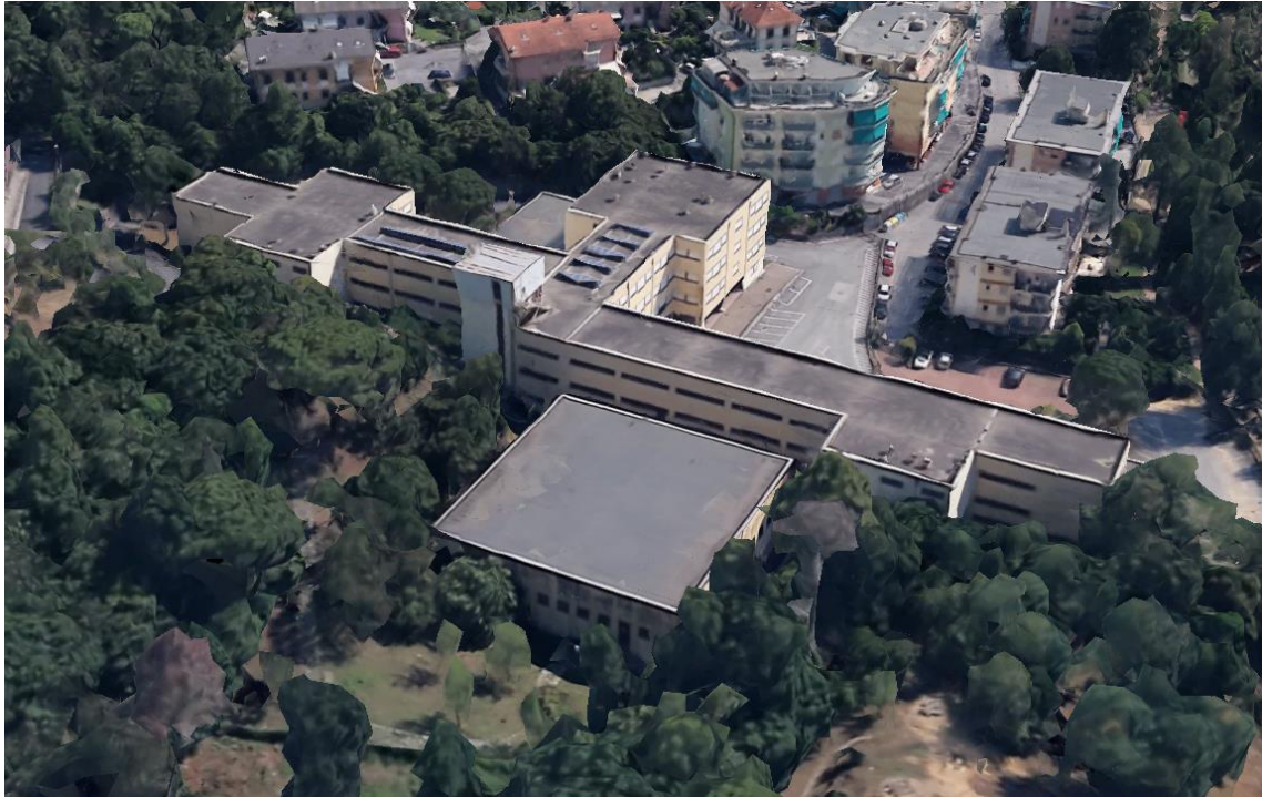
Figura 7 - Vista del fabbricato da nord
