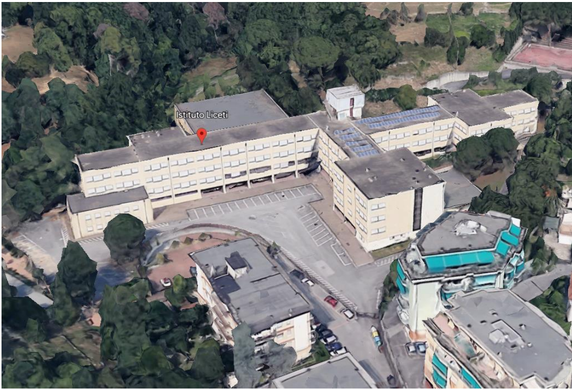
Figura 5 – Vista del fabbricato da sud-ovest
