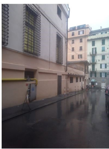
Ingressi laterali da videosorvegliare
