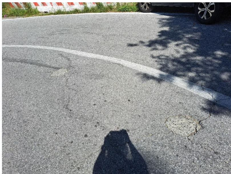
FOTO 1: Fessurazioni e segni sul manto stradale
