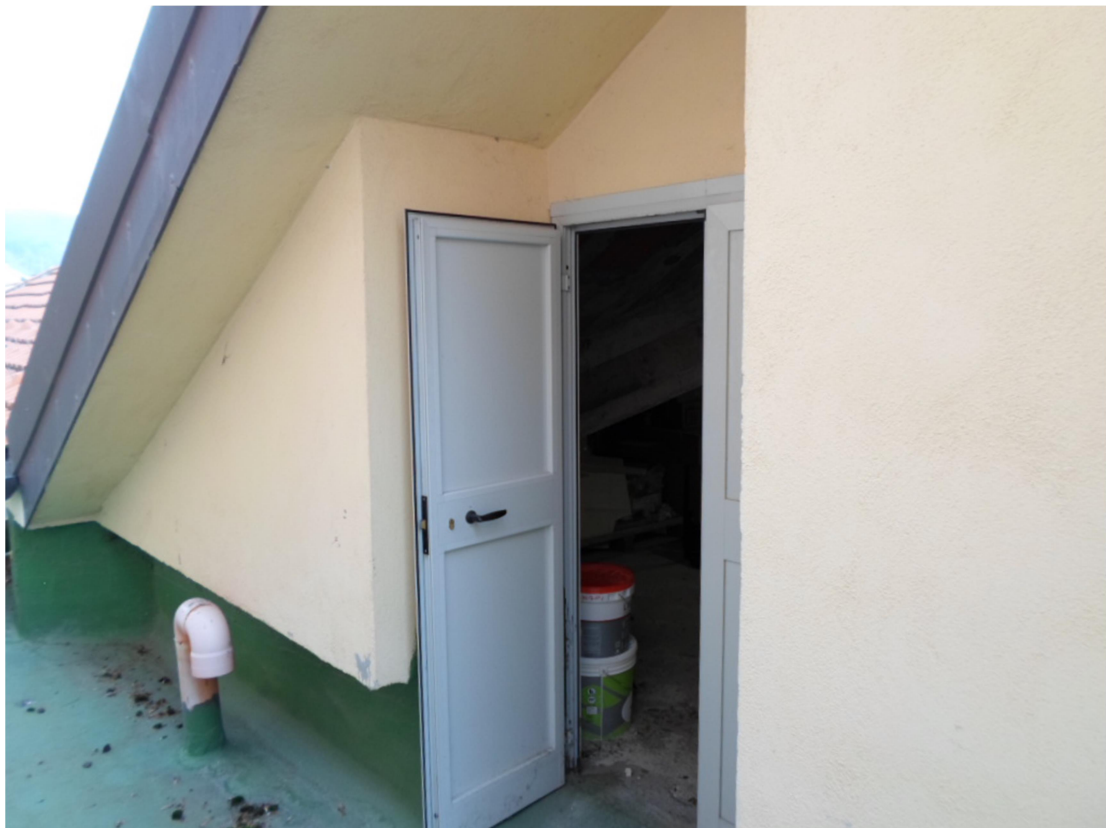
Figura 4_Porta d'ingresso al locale
