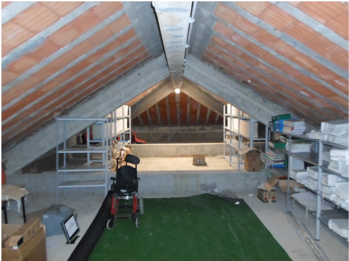
Figura 2_Vista interna locale sottotetto
