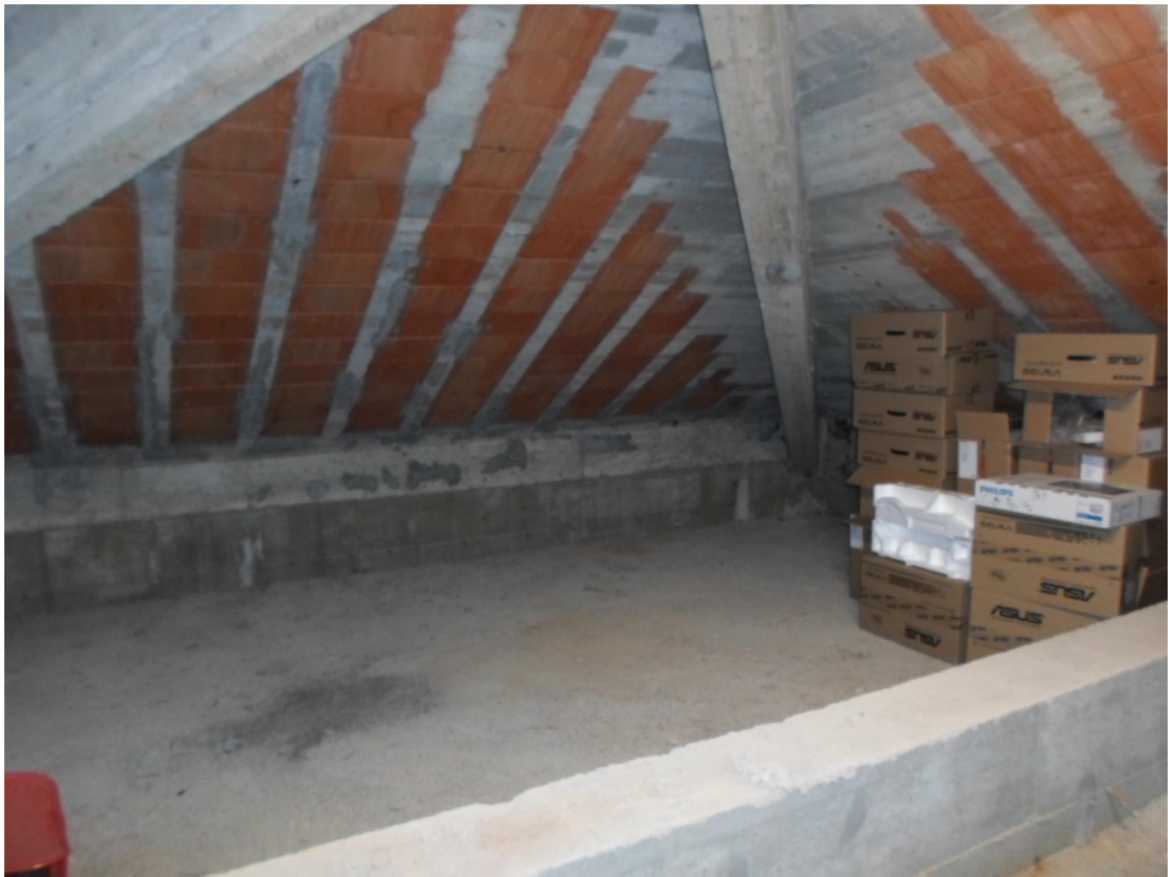
Figura 1_Interno locale sottotetto
