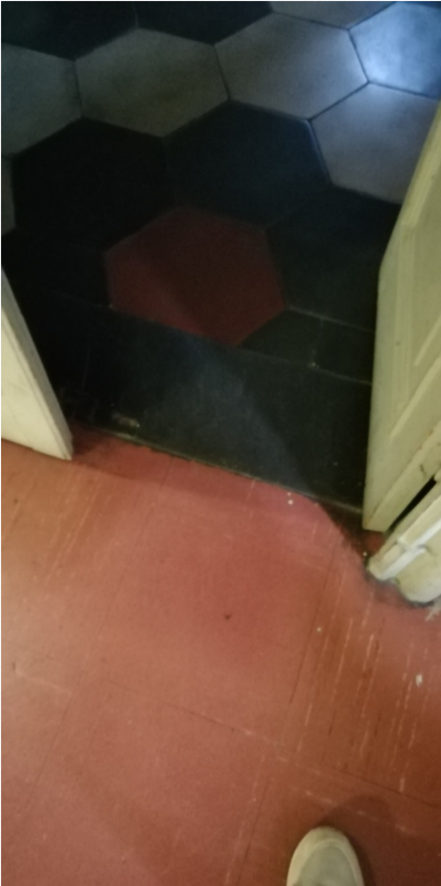
Foto n° 6 – ingresso ufficio D.S.G.A.
