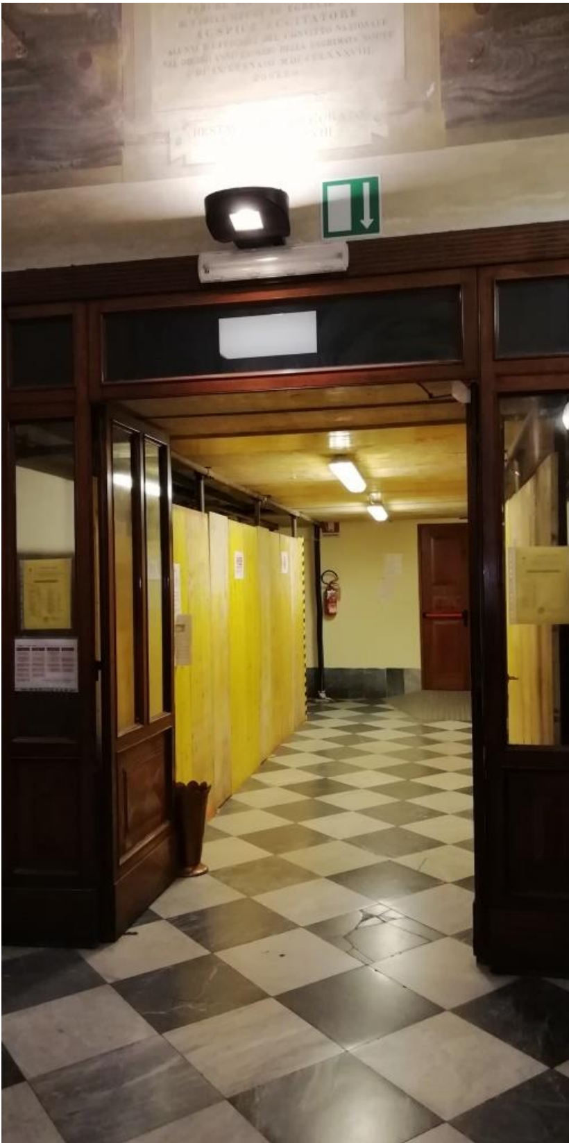
Foto n° 11 – galleria napoleonica – zona sopralcata da ripristinare
