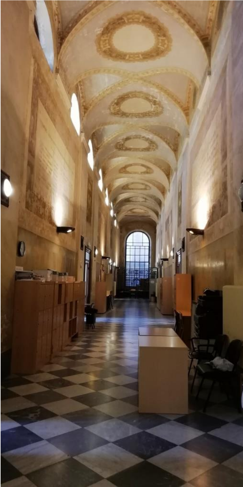
Foto n° 9 – galleria napoleonica – volte e superfici murarie da restaurare
