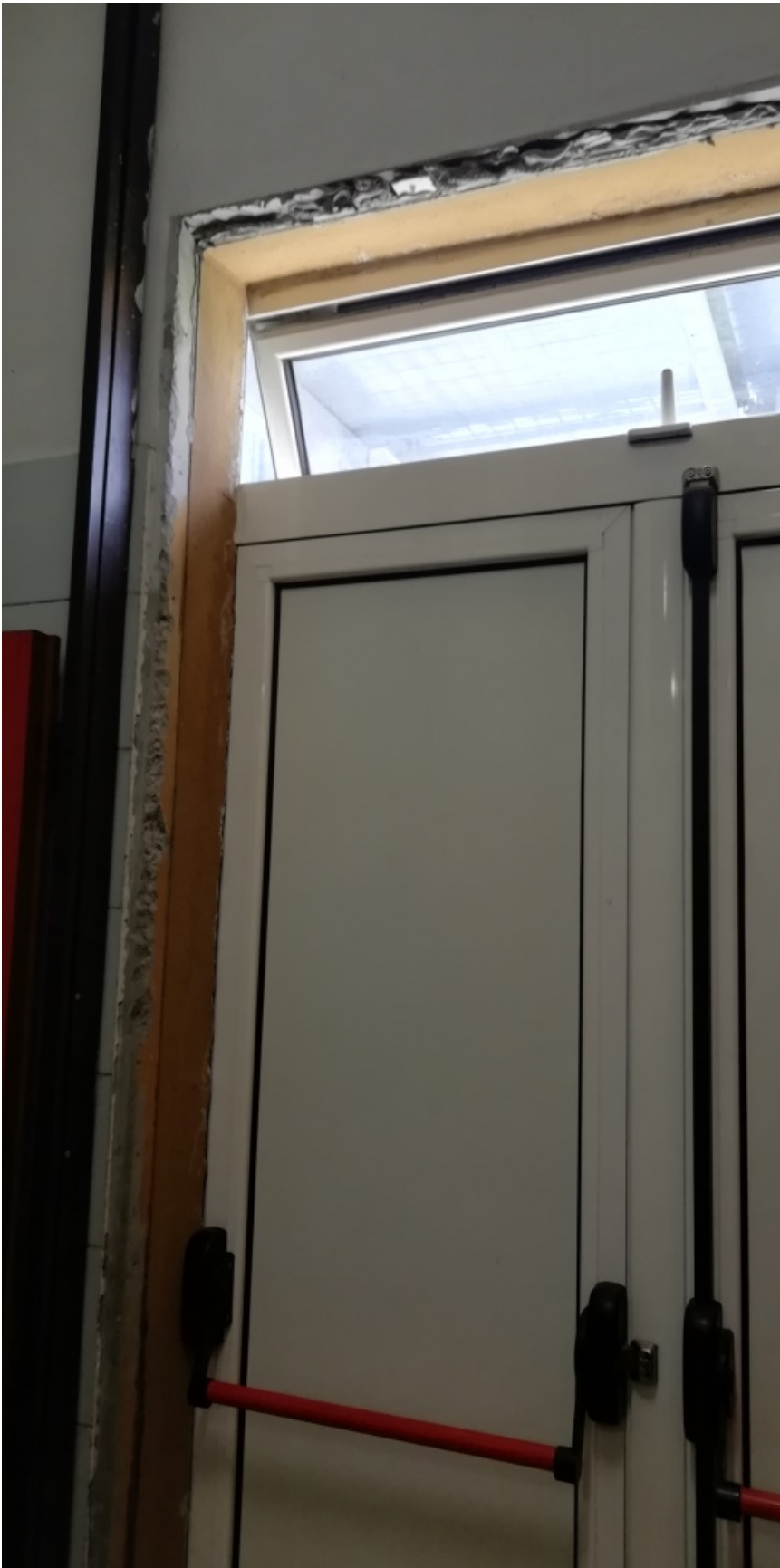
Foto n° 5 – verifica resistenza al fuoco parete esterna
