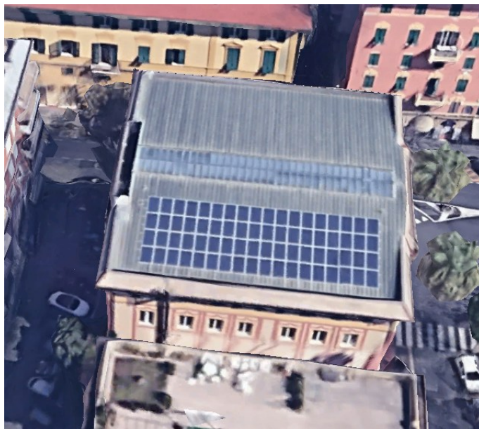
Figura 27: Impianto fotovoltaico esistente
