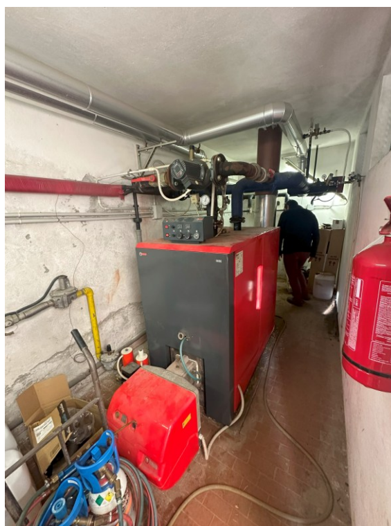
Figura 14. Locale centrale termica
