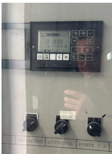
Figura 23. Regolatore di centrale con orari di funzionamento
