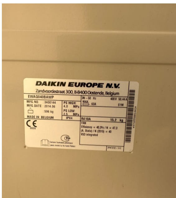
Figura 15. Targa del gruppo frigo esistente
