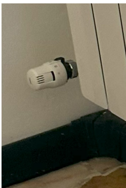
Figura 24. Valvola termostatica su radiatore
