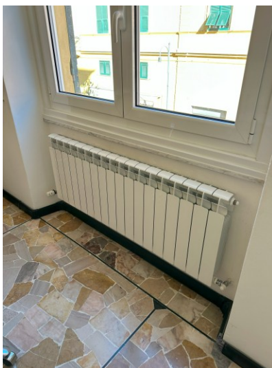
Figura 18. Radiatori in alluminio
