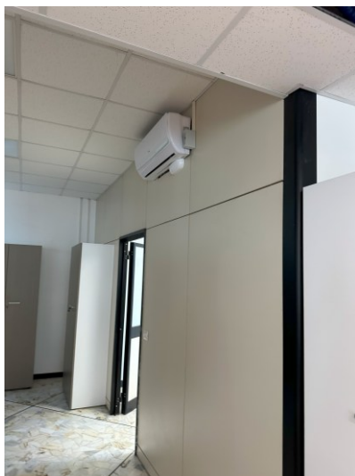
Figura 21. Fan-coil a parete
