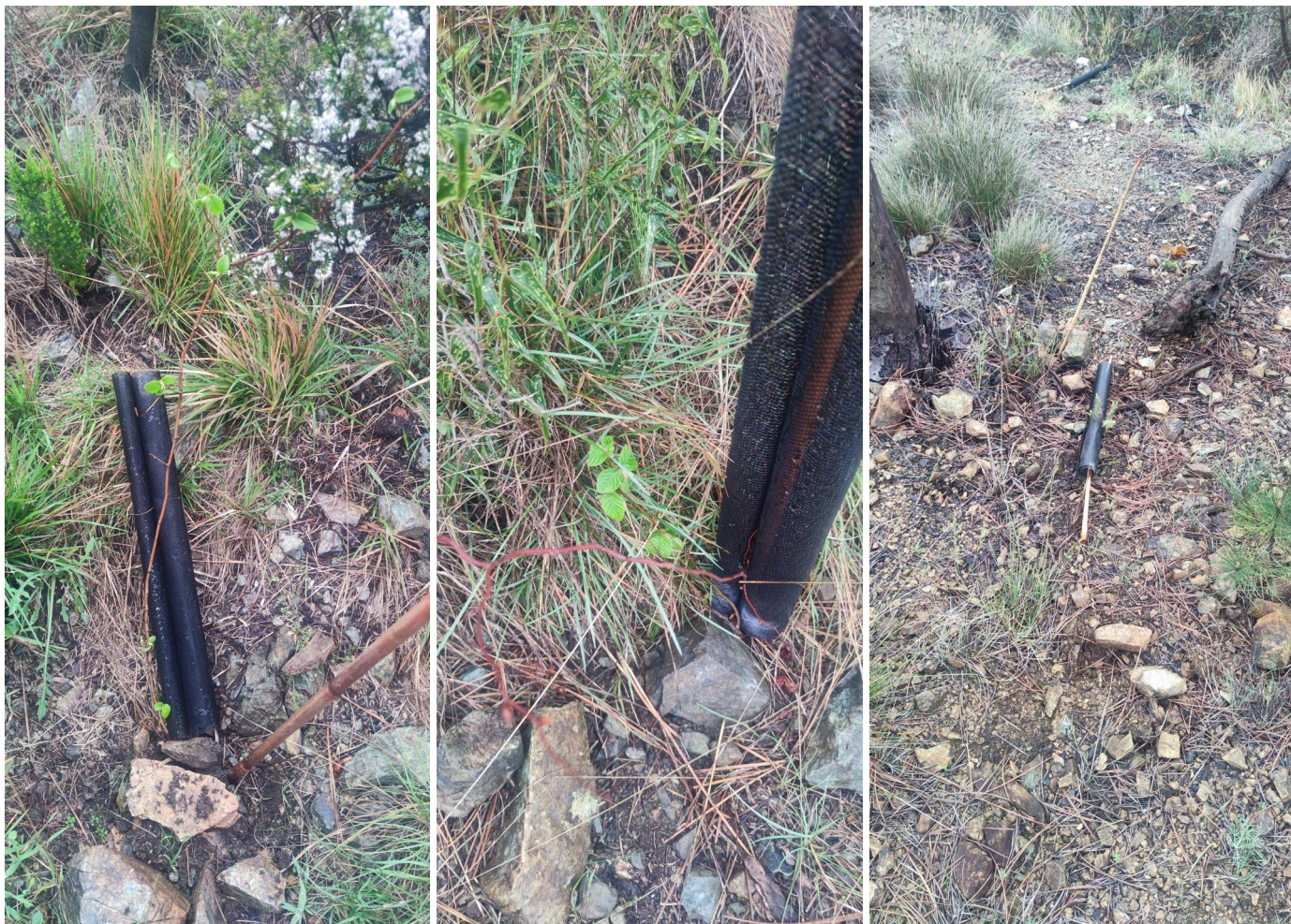
Foto 10. Shelter di protezione fuori asse da sistemare
